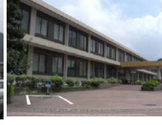
【鹿児島県民総合保健センター】
