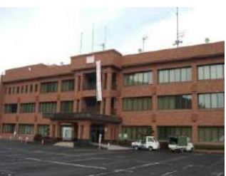
【鹿児島市政府 松元支所庁舎】
