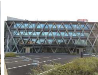
【豊海本社ビル】
