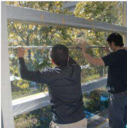
スポンジバー工法
