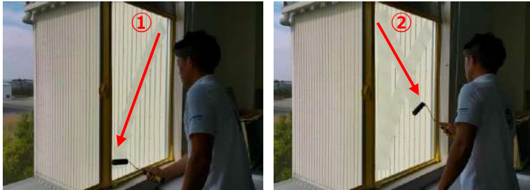
2) 対角線状(エックス)にローラーを転がす
