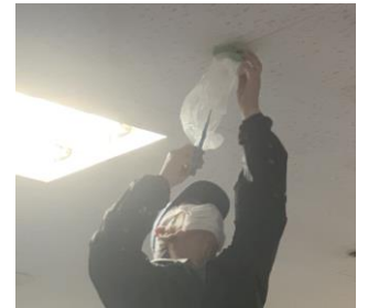
煙探知機へのビニールマスクでの養生
