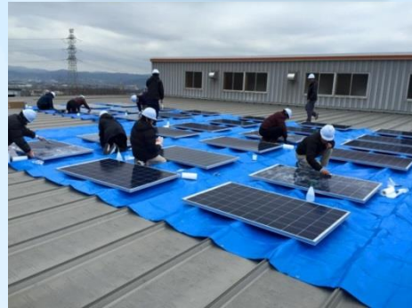
大阪にて1500㎡ (パネル1,000枚)施工
