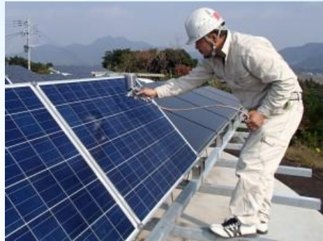
鹿児島県にて70㎡施工
