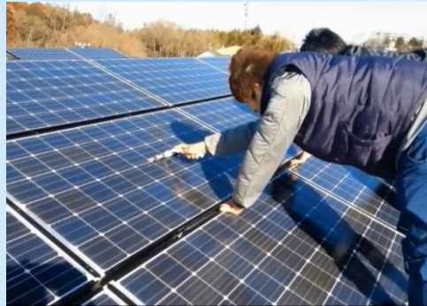
茨城県にて100㎡施工
