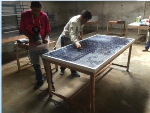
ネパールにて施工
