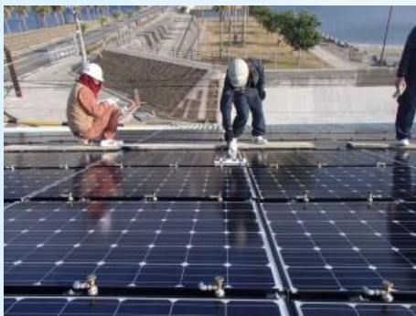
鹿児島県にて310㎡施工
