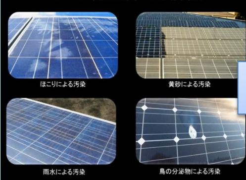
モジュール表面の汚染による効率低下
